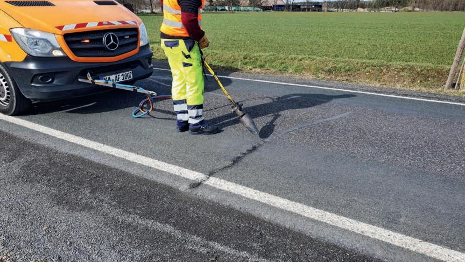
Die Heißluftlanze erzeugt eine Druckluft von bis zu 8 bar und eine Temperatur von rund 500 °C.
