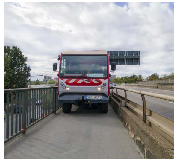
Jegliche schmale Verkehrsfläche kann so saniert werden
