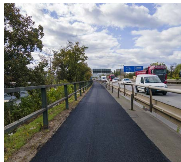
Am Ende steht eine schnell und kostengünstig sanierte Verkehrsfläche zur Verfügung
