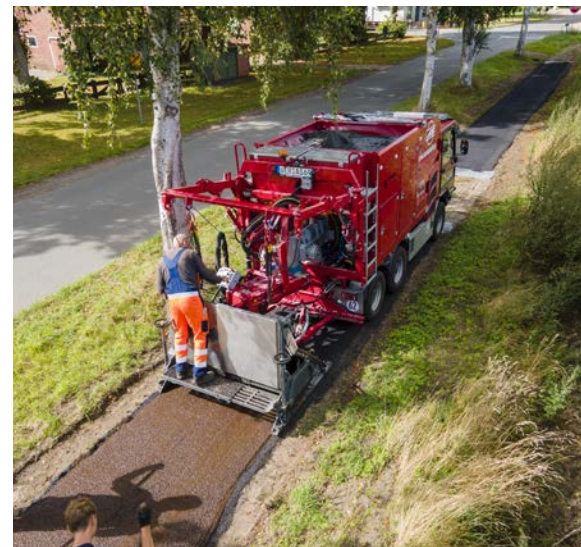
Der maschinelle Einbau erfolgt in variabler Breite zwischen 1,40 und 2,10 m
